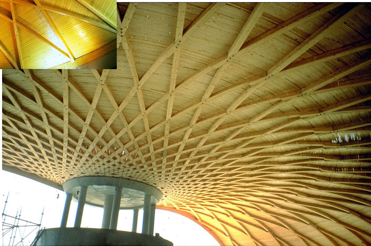
Piscine de St-Quentin Architecte: M. Carduner et associés Ingénieur: ICS Bois M. Flach, J. Natterer
