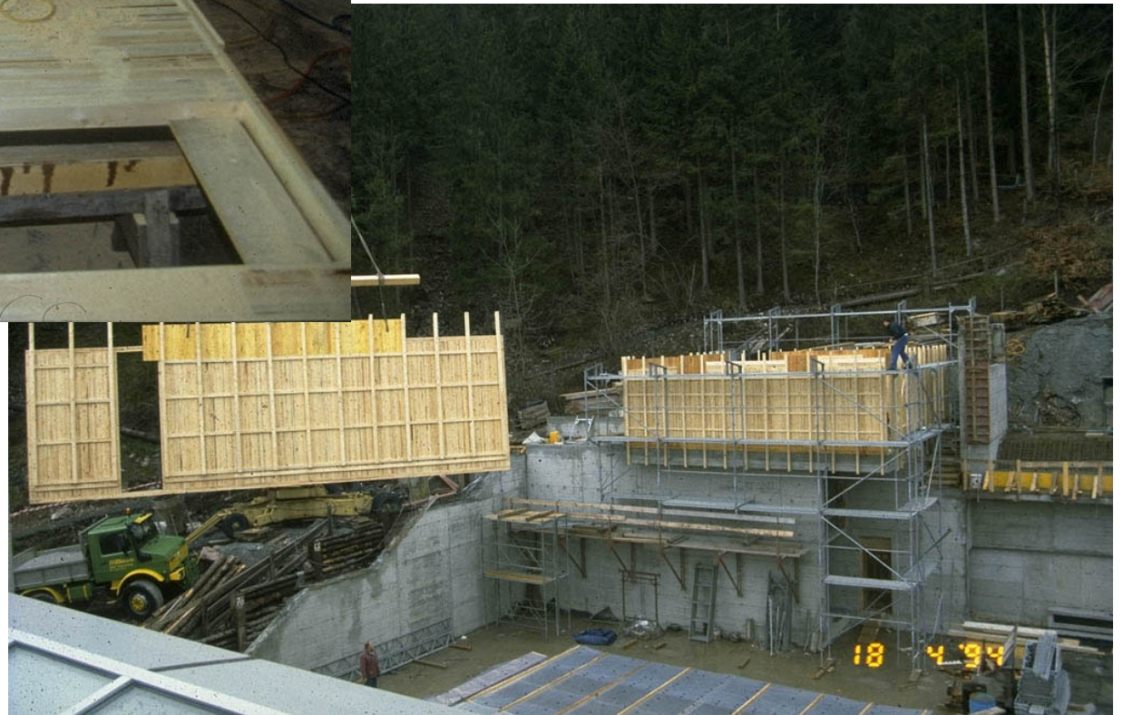
Habitation à Trisenberg Architecte: Ospelt und Freund Architekten Ingénieur: Bois Consult Natterer SA
