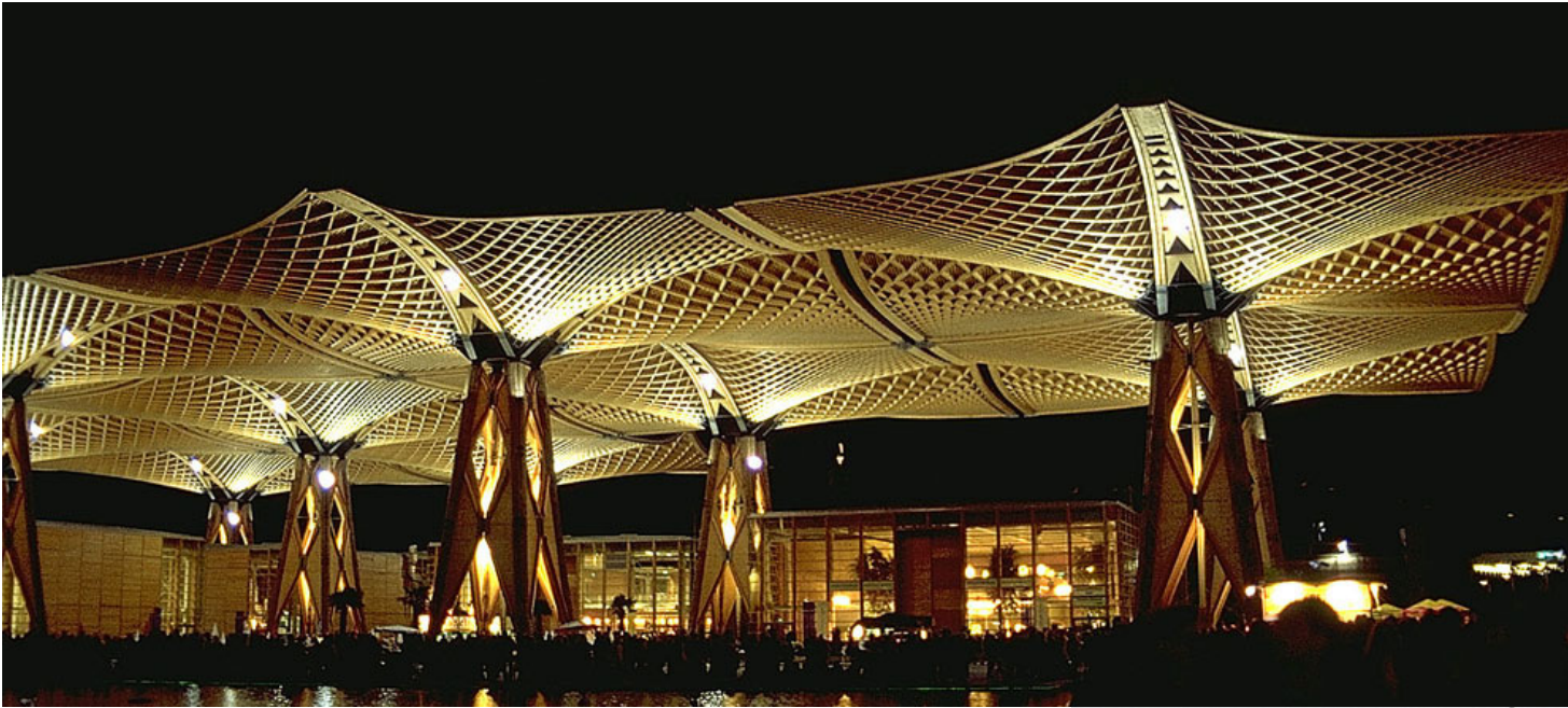
Toiture de Hannover Architecte: Herzog und Partner Ingénieur: IEZ Natterer GmbH
